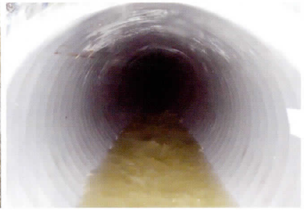
写真3 管路施設改築工事 （久慈幹線その10） 施工後
