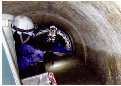
写真2 管路施設改築工事 （久慈幹線その10） 施工中
